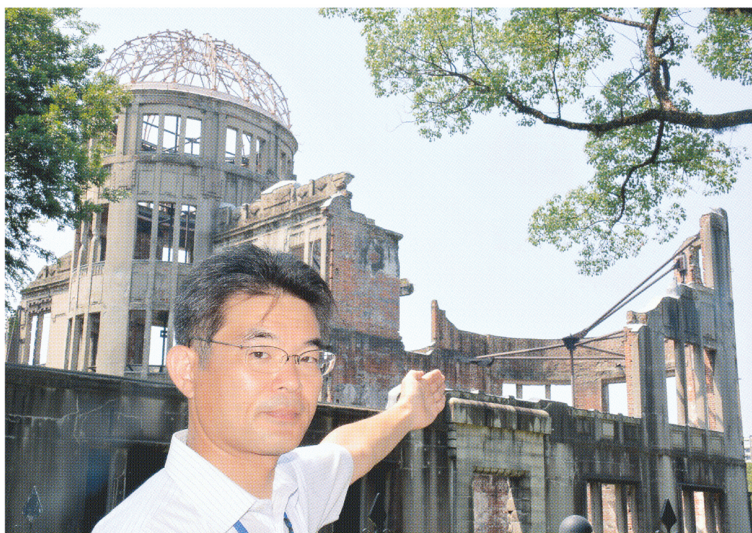
地震対策工事で取り付けられた鉄骨を指し示す和泉さん。崩れかけた壁を補強している。広島市中区
